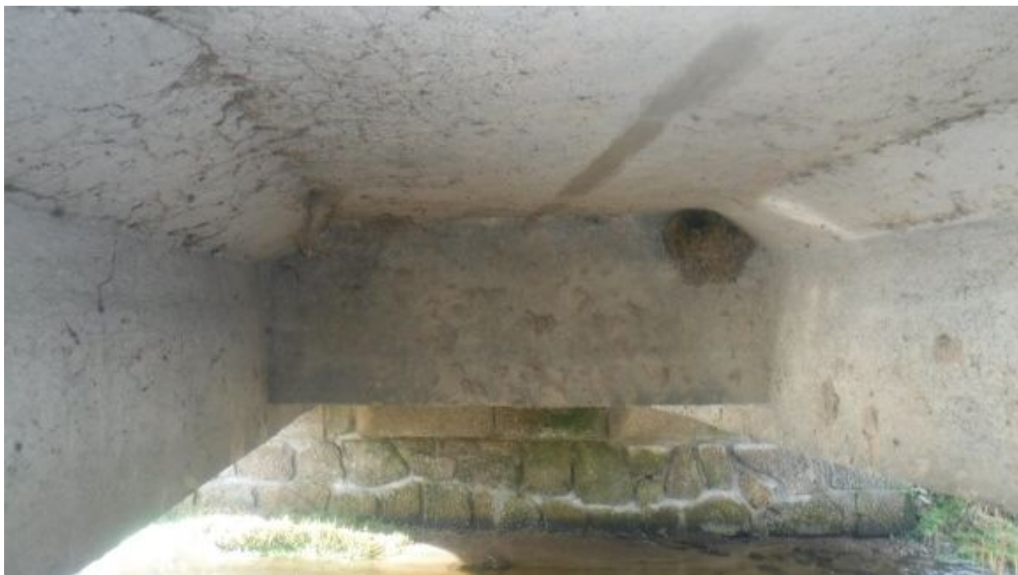
056 Ztužidlo nosné konstrukce
