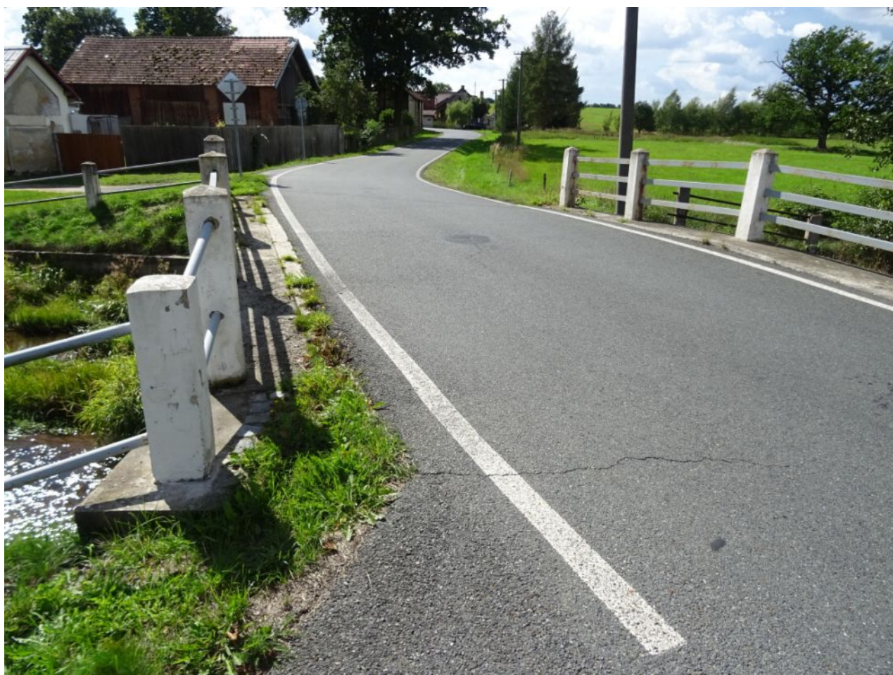
008 Trhlina ve vozovce v předpolí mostu
