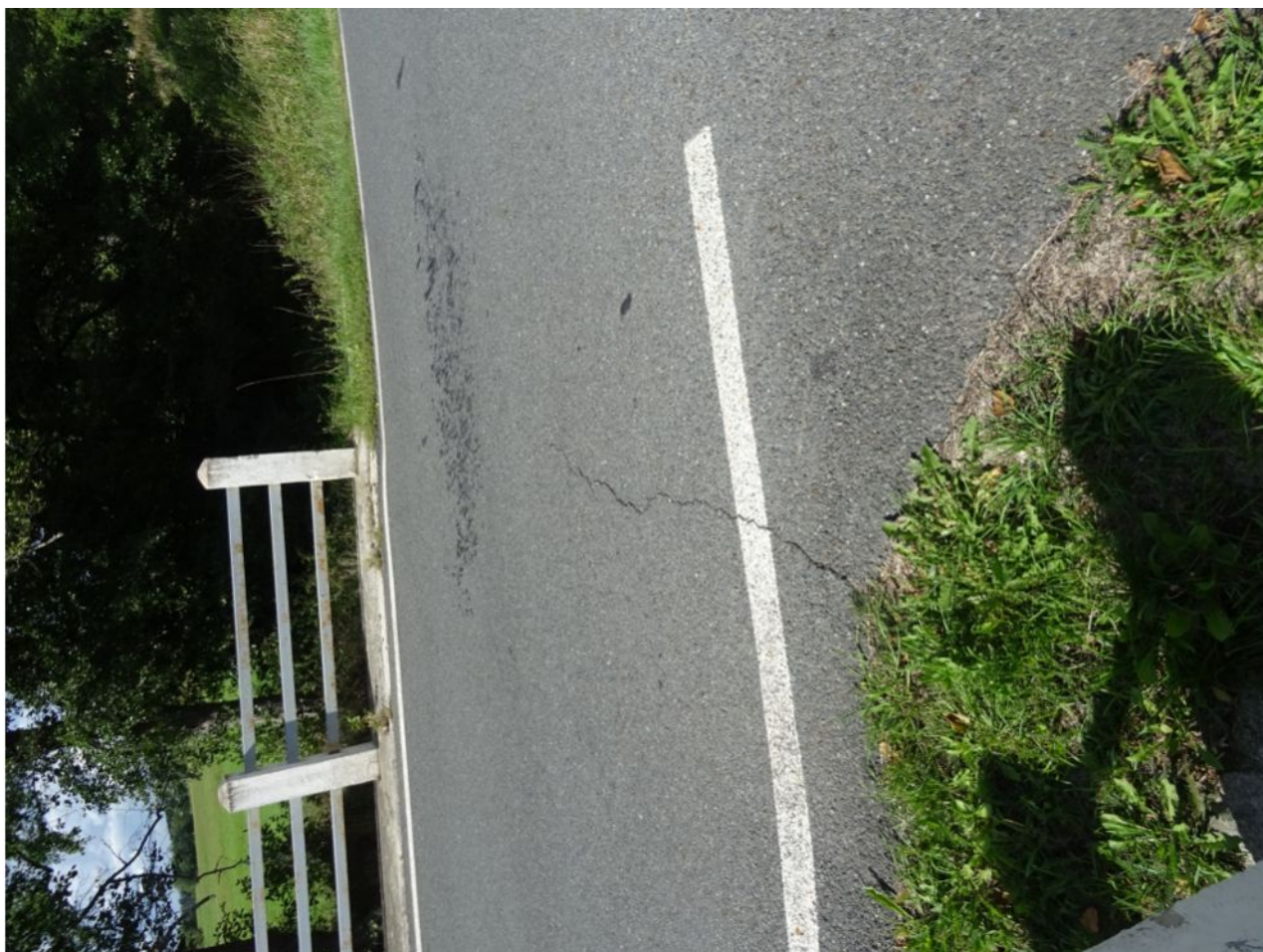
009 Trhlina ve vozovce v předpolí mostu
