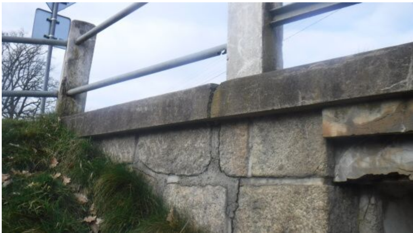
058 Trhliny ve spárování zdiva křídla-návodní strana
