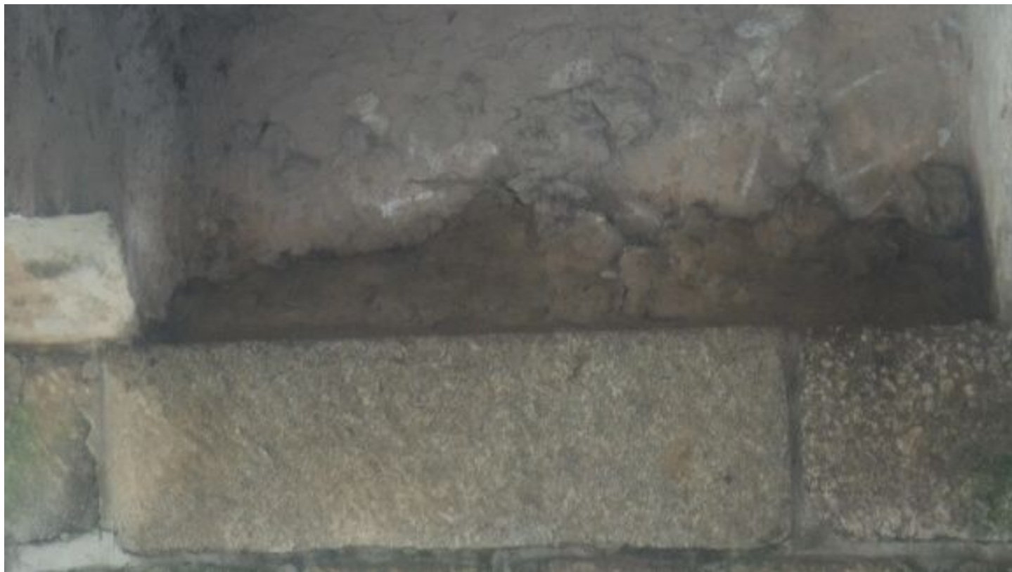
057 Bahno na úložném prahu mostu
