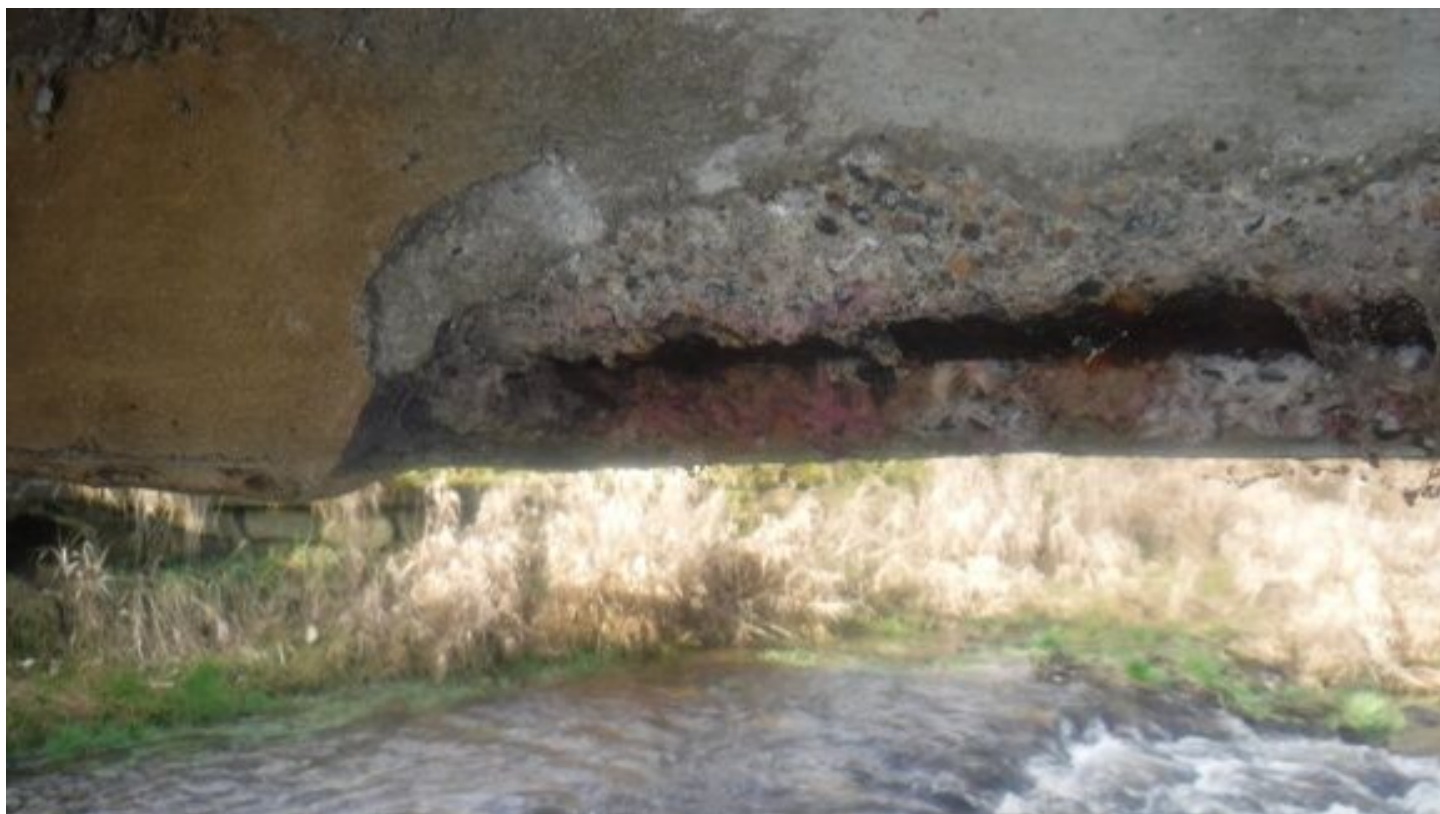
054 Poruchy v nosné konstrukci
