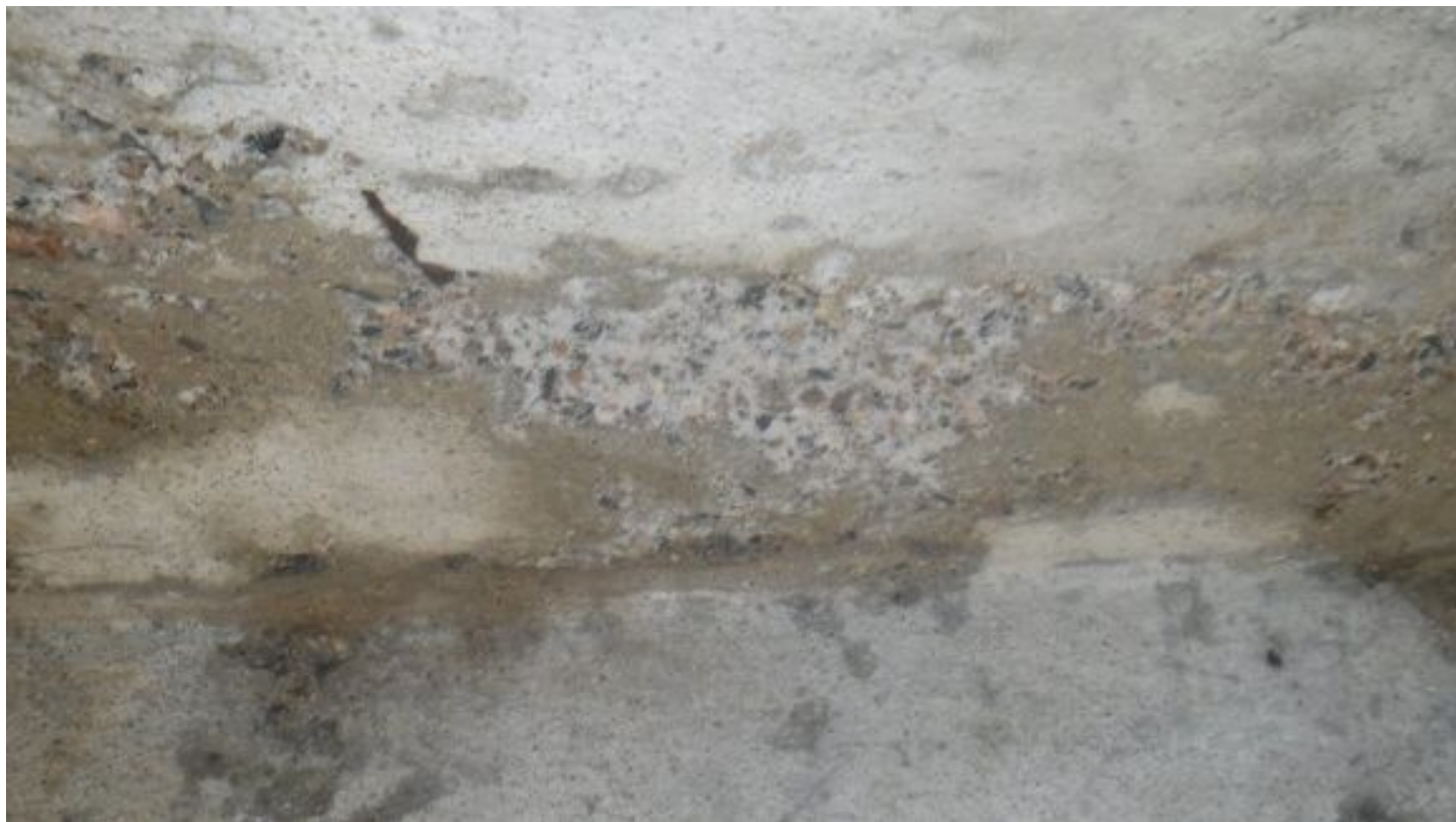
055 Průsaky vody a výkvěty ve vodě rozpustných solí
