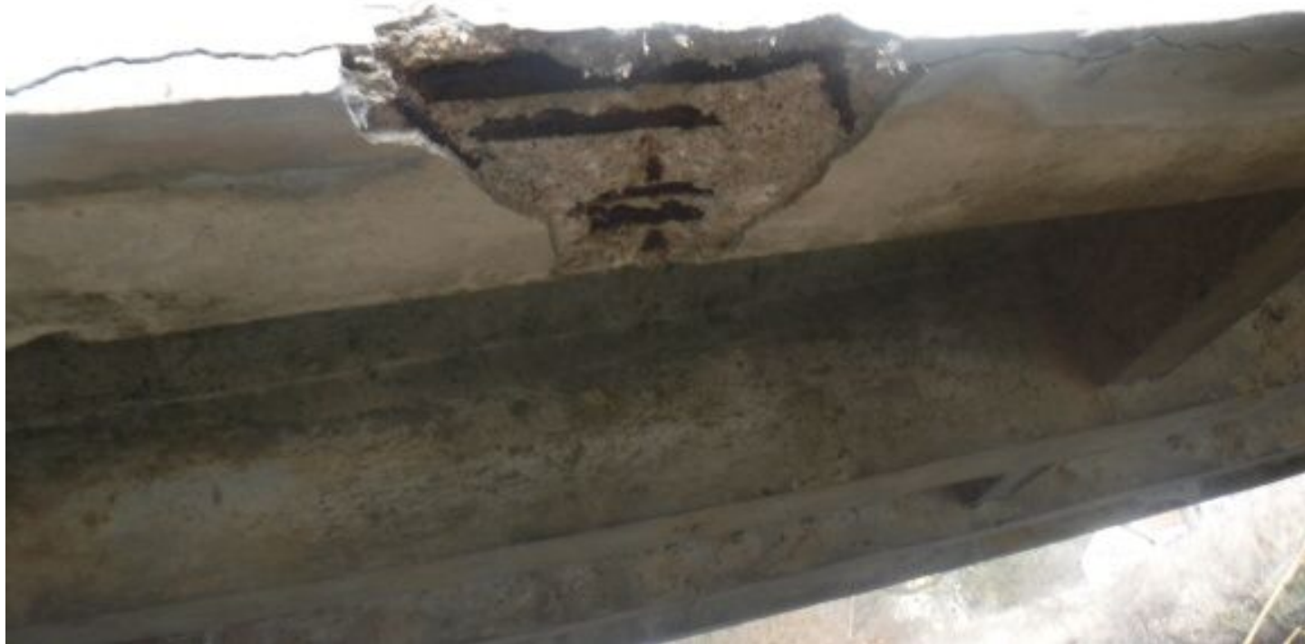
049 Poruchy v nosné konstrukci
