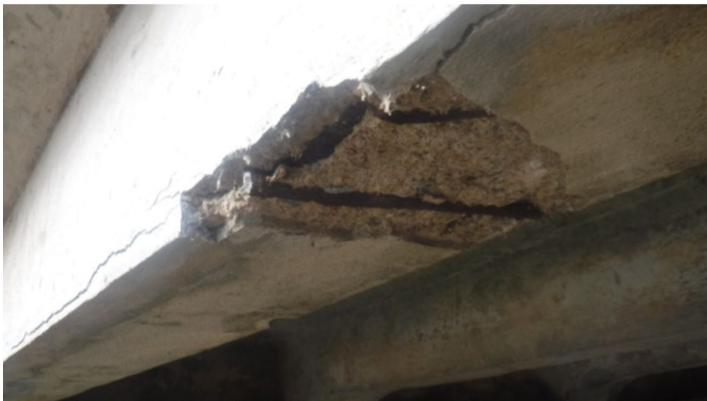
047 Poruchy v nosné konstrukci
