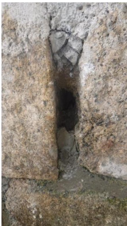
Obr. 2 Spára ve zdivu
