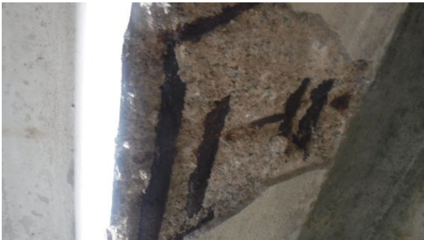
048 Poruchy v nosné konstrukci
