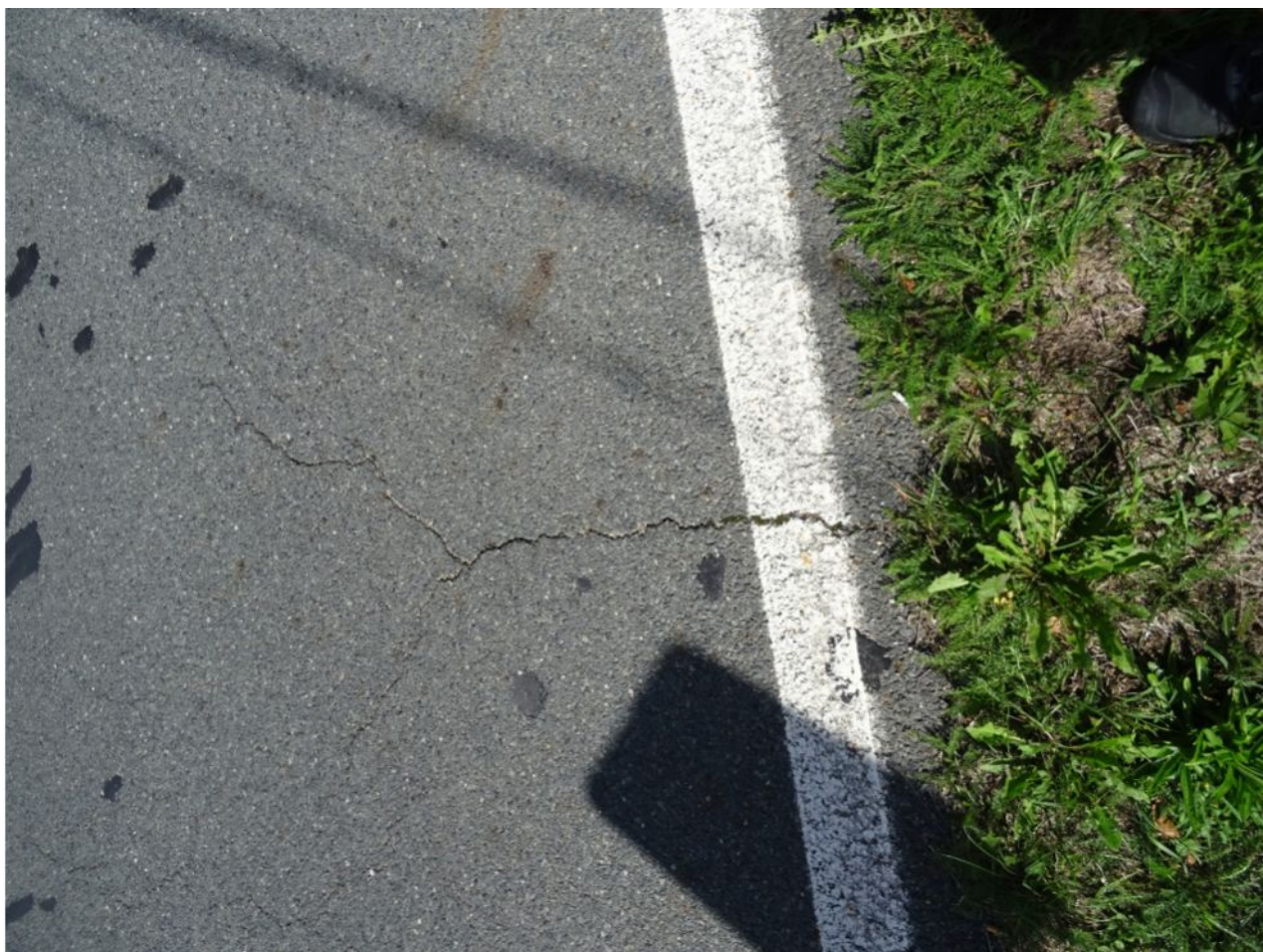
010 Trhlina ve vozovce v předpolí mostu
