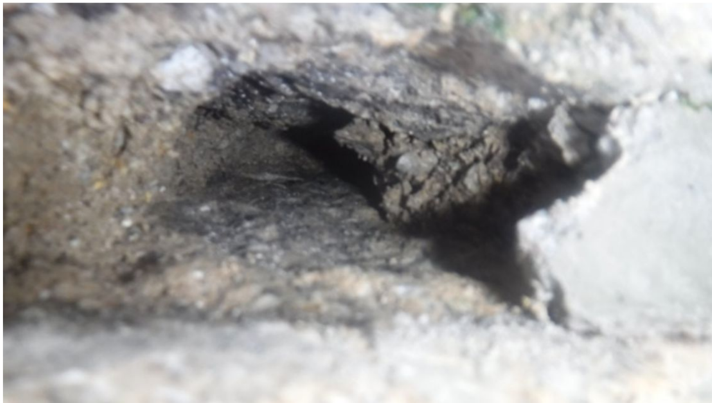
061 Spára ve zdivu-detail
